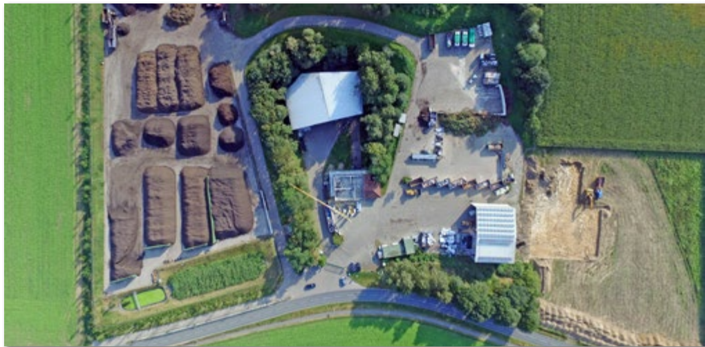
Die ersten Baumaßnahmen in Ankum aus der Luft betrachtet.
