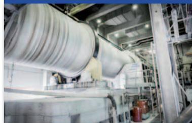
In der Trommel werden die Fasern des Altpapiers in einen Brei aufgelöst und im Flotationsverfahren entfärbt.
